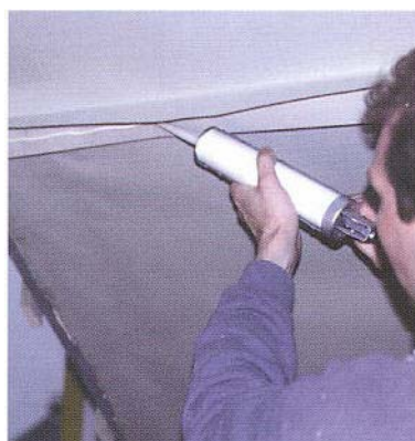
Abb. 12: Verdeckte Leckagen werden gefunden und beseitigt mit Dichtmitteln oder Dichtklebeband
