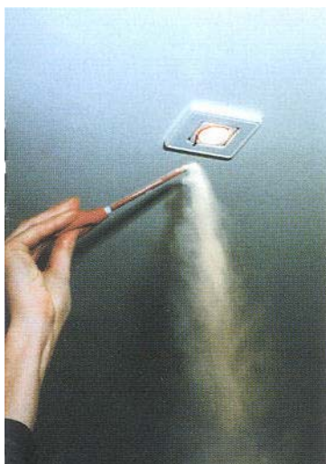
Abb. 11: Leckagen suchen – einströmende Luft wird mit freigesetztem Rauch sichtbar gemacht
